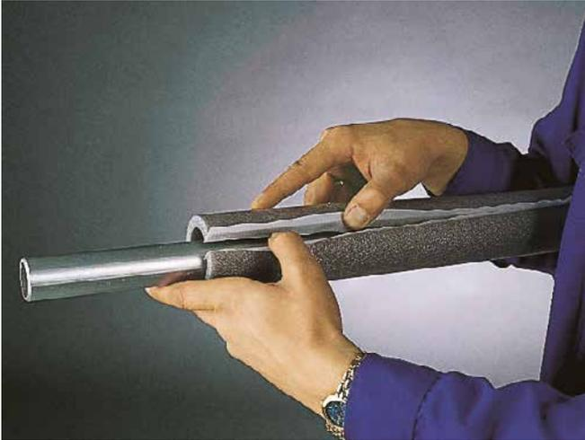
Der bereits geschlitzte steinojet® 410 Isolierschlauch wird „aufgeklappt“ und um das Rohr gelegt.
