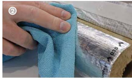
Vor dem Verschließen ist die **Rohrschale** passgenau zusammen zu drücken. **Es ist darauf zu achten, dass vor dem Schließen des Klebebandes alle Klebestellen staub-, fettfrei und trocken sind!**
