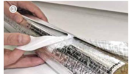
Schutzfolie der werkseitig aufgebrachten, selbstklebenden Überlappung abziehen und Längsschlitzung verkleben.
