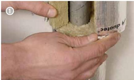
Die **Rohrschale** mit Aluminiumkaschierung ist einseitig geschlitzt und lässt sich durch Aufklappen um das zu dämmende Rohr legen.
