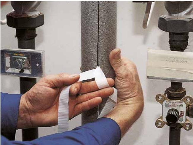
Die Abdeckbänder werden von der Schlauch-Längsnaht abgezogen. Danach wird der Längsstoß zusammengepresst.
