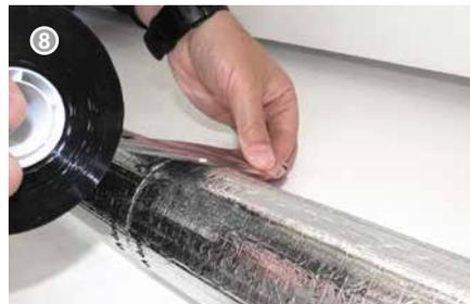
Querstöße der Schalen sind fugenfrei zu verlegen und zusätzlich mit geeignetem Klebeband des Herstellers zu sichern. Klebebänder generell mit Isolierspachtel glatt und fest andrücken.
