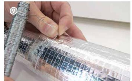
Die Rohrschalen ist zusätzlich mit weichverzinktem Bindedraht zu sichern (bei Brandabschottung mit duotec® min. 6 Umwicklungen pro Meter).
