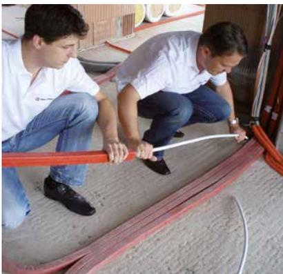
Dämmung keinesfalls auf bereits in Betrieb befindlichen „heißen Rohren“ anbringen. Bei Dämmarbeiten sind genaue Maße zu nehmen, **alle Schnitt- und Stoßkanten sind mit steinoflex® Spezialkleber dicht und kraftschlüssig zu verkleben**. Alle Schlauch-Querstöße sind mit steinonorm Spezial-Kunststoff-Klebeband oder steinoflex® Gewebeklebeband rot zusätzlich zu umwickeln. Klebebänder immer überlappend verkleben.
